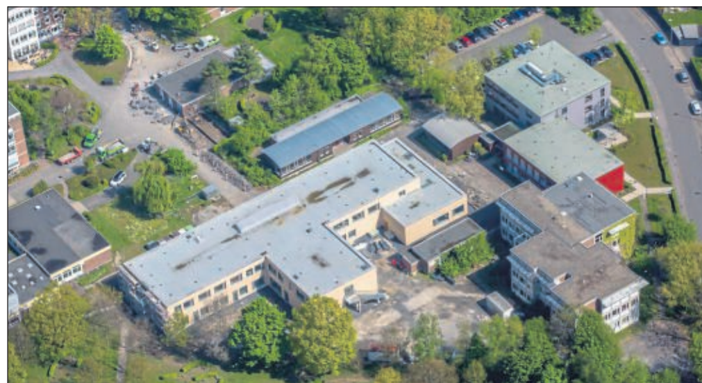
Noch liegen sie nebeneinander, der helle Neubau und der dunkle Altbau an der Reierstraße (Gebäude rechts unten). Nach über 40 Jahren wird das Schulgebäude abgerissen. ■ Foto: Blossy
