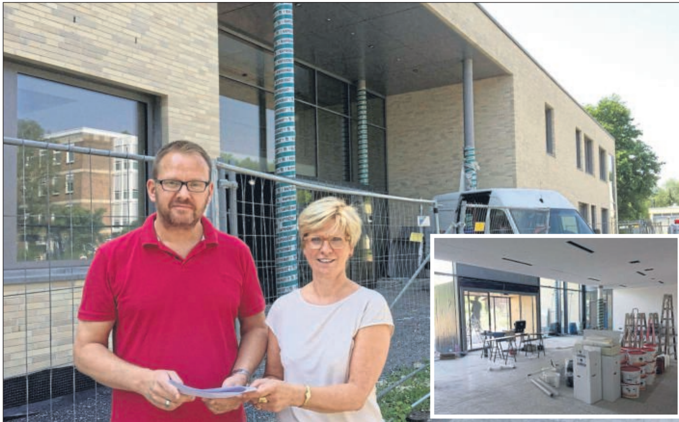
Während im Schulneubau Malerarbeiten erledigt und Böden verlegt werden, sprechen Tilo Berendt, bauleitender Architekt, und Schulleiterin Marianne Marbach über den Zeitplan. ■ Fotos: Haarmann
